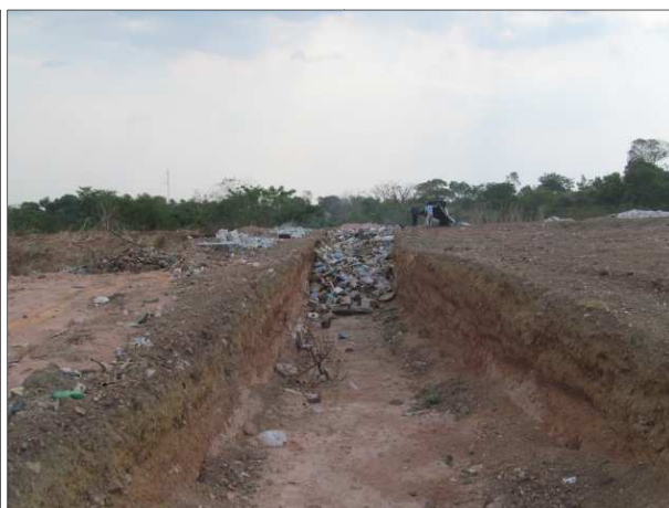
Foto 4.2 – Disposição dos resíduos sólidos em valas no lixão de Pequizeiro
